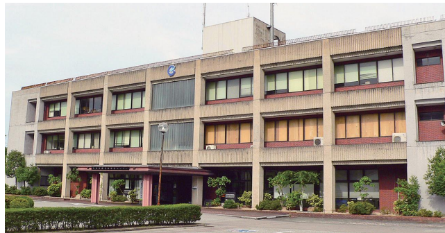
解体前の旧能登島市民センター
