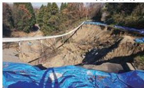
崩落した県道城山線
