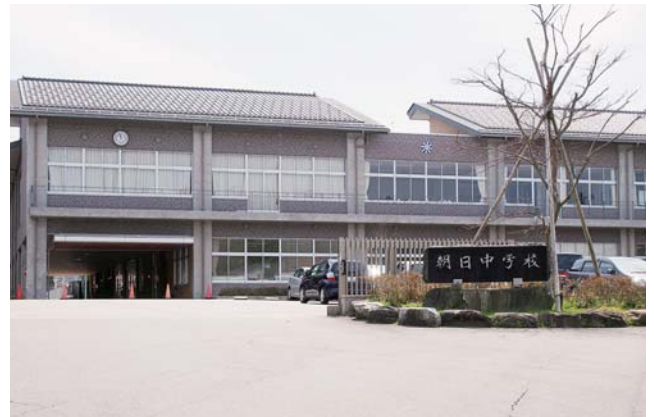
平成30年度から朝日小学校になる旧朝日中学校
