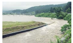
豪雨により氾濫寸前の熊木川
