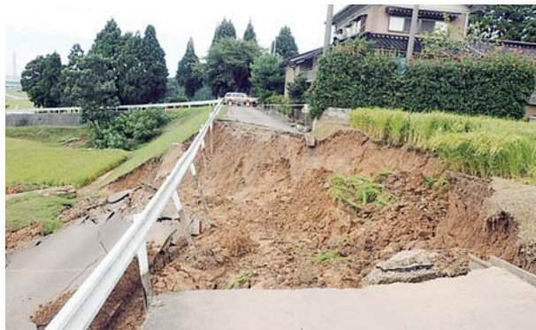
豪雨による災害状況
